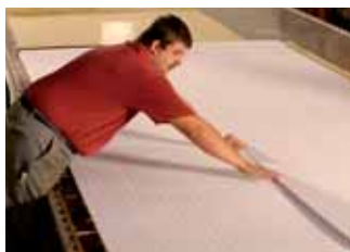
pose de l'isolant
