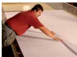
pose de l'isolant
